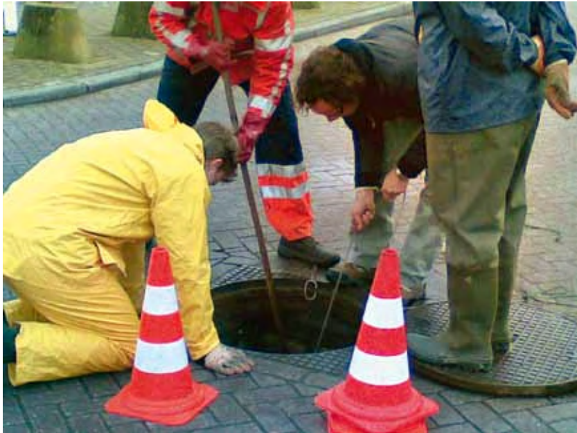
Figuur 4.4 Kabel van put naar put trekken
