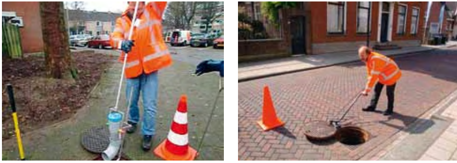
Figuur 5.5 Plaatsing geluidsbron in put
