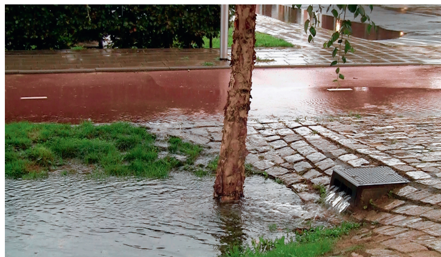
Overloop van een wadi via een kolk.
